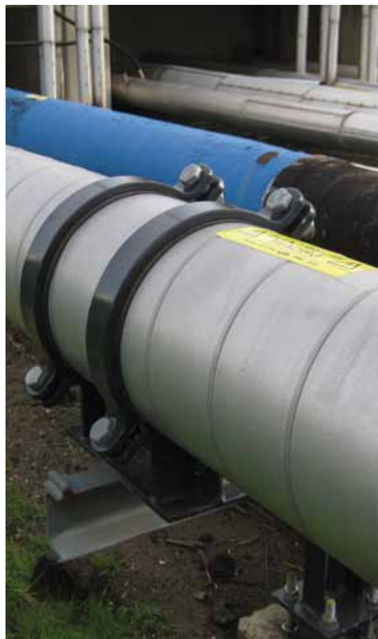
Трубные опоры, крепящиеся к кожуху теплоизоляции, гарантируют равномерный тепловой профиль на всей протяженности трубы.
